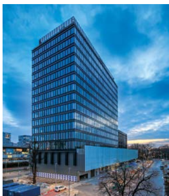
Polyfunkční centrum Einsteinova, Bratislava, Slovensko
