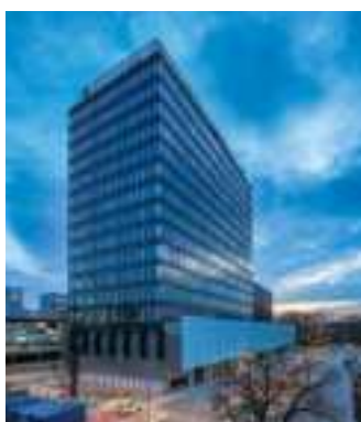
Polyfunkční centrum Einsteinova, Bratislava, Slovensko
